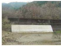
堤体前面に張りコンクリート
