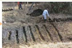
土砂堆積部分の浚渫
