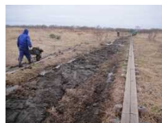
水抜き水路の埋め戻し
