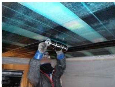
炭素繊維シート接着状況
