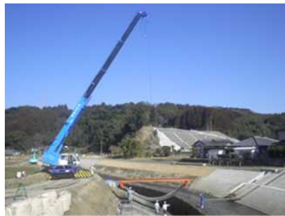
ブロックマット据付状況
