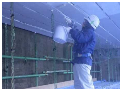
仕上げ塗装状況
