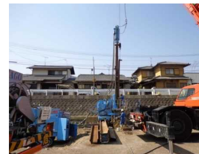
鋼矢板圧入状況
