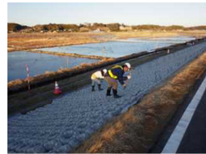
アンカーピン打設状況
