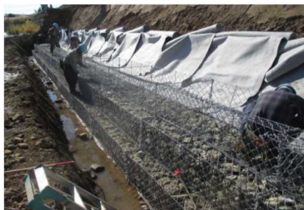
かご組立・据付状況
