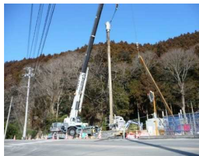
鋼矢板吊り込み状況
