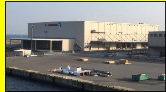
①上組 神戸空港国際物流センター (神戸市中央区)[3.6万㎡]
