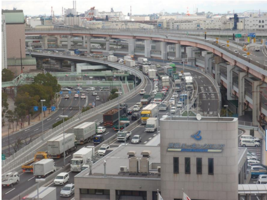
阪神高速神戸線 京橋ランプを望む(東行)
