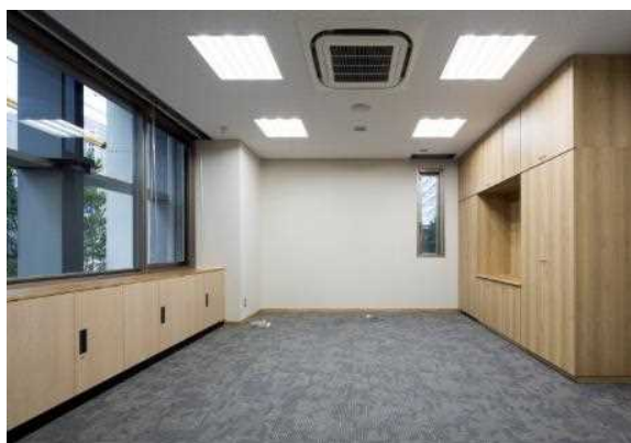
○ 財務省 税務大学校広島研修所※ (使用部位：庁舎・教室棟 額縁、家具)
