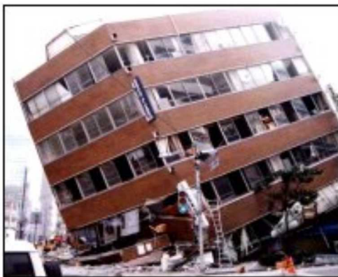
事務所ビル1, 2階の崩壊
