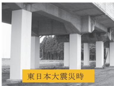
【高架橋の補強】
