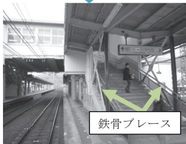
【橋上駅の補強】
