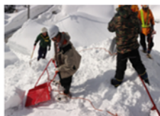
転落防止対策(命綱、アンカー)
