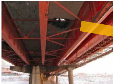
橋梁のコンクリート床版の損傷事例(国道4号白川橋)
