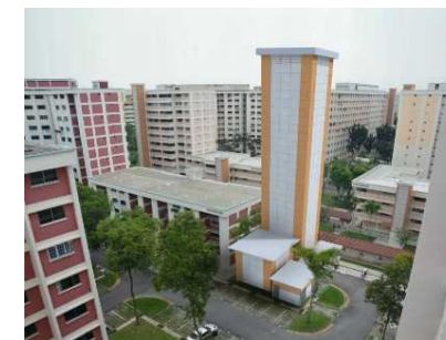
Yishun Avenue 4 Car Park Y39 エレベータパーキング1基 駐車台数26台
