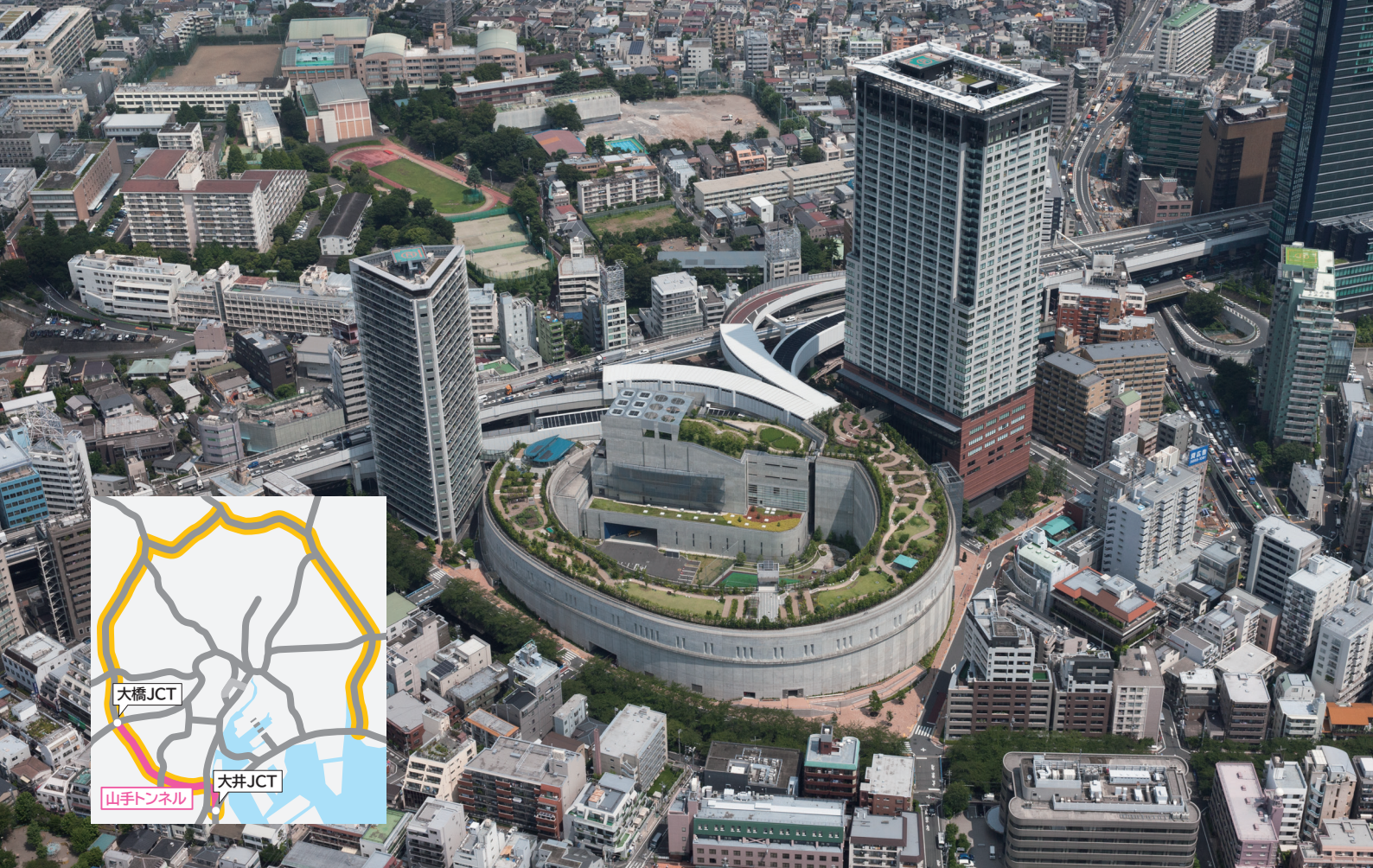
今年3月に全線開通した中央環状線で、3号渋谷線との接続部である大橋ジャンクションの空撮写真。中央環状線の「環」が完成したことで、中央環状線の利便性は大きく向上。また写真のように、高速道路施設の屋上エリアを公園として公共空間にするなど数々の新しい試みも注目されている。
