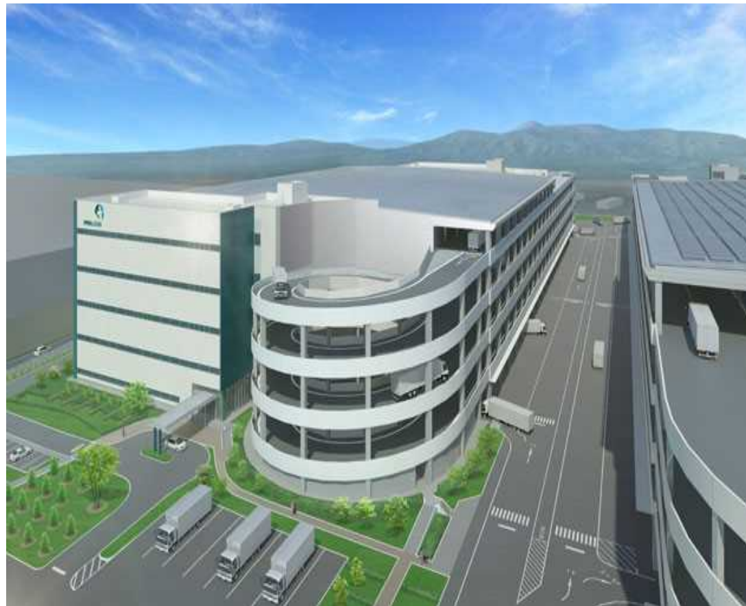
プロジスパーク座間2 (延床約115,000㎡、2012年9月竣工)
