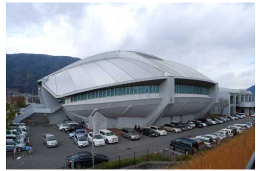
安佐北区スポーツセンター
