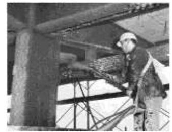
湿式吹付け施工状況
