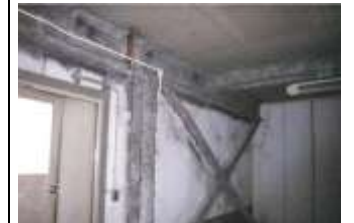
鉄骨の耐火被覆
