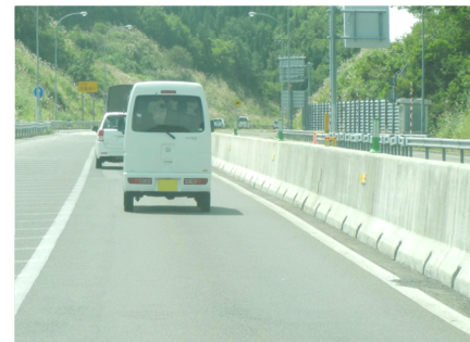
<コンクリート防護柵>
