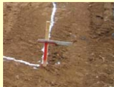
MC無し区間 (丁張り設置状況)
