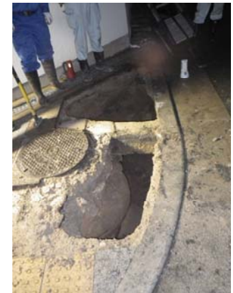
■ 管路施設に起因した道路陥没の事例
