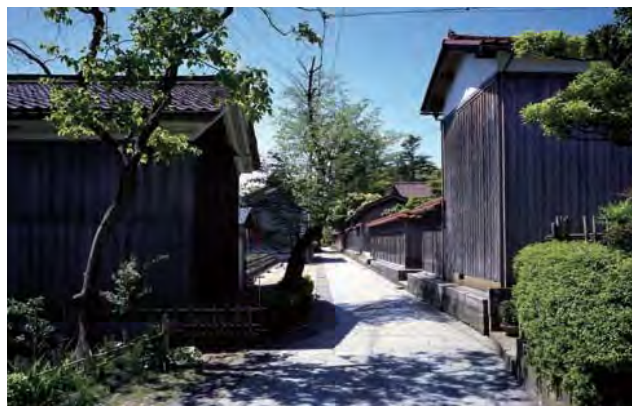
通りに面して、板塀や土蔵等の付属屋が配される。板塀や土蔵は保存別件として修繕、また街路整備が実施され、伝統的建造物に調和した街路空間が整備されている。
