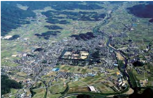
篠山城下町地区全景。周囲を田畑に囲まれ、北は多紀連山県立自然公園、南東部に篠山城下町形成前の拠点であった中世山城八上城跡を望み、現在も近世城下町の姿をよくとどめている
