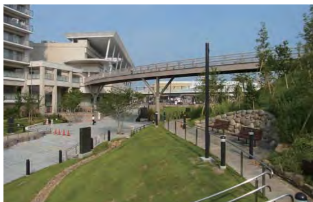
ゆるやかに弧を描きながら無理なく高低差を解消する市民広場の斜路とデッキ。
