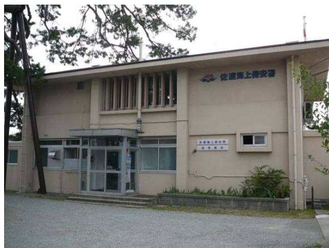
既存庁舎外観
