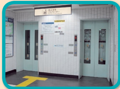
西早稲田駅は、地上に出るルートに20人乗りの大型エレベーターも整備しています
