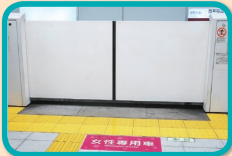
西早稲田駅はハーフハイトタイプのホームドアが整備され、転落事故や接触事故を防いでいます
