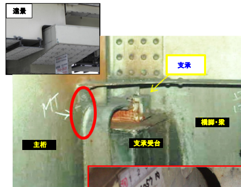
【鋼桁の接続部(切欠き部)】
