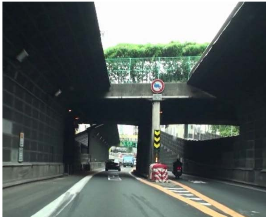
車道内橋脚の事例
