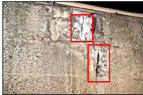
コンクリート剥離・鉄筋腐食
