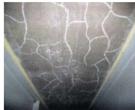
コンクリート床版の亀甲状ひび割れ
