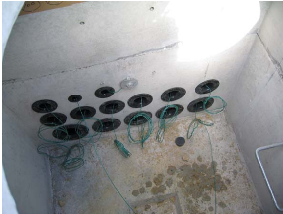
写真一 1 愛知万博電気工事
