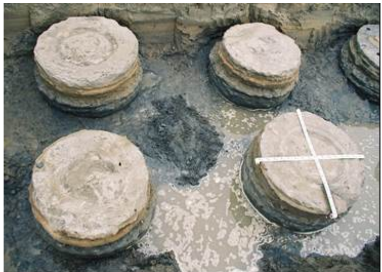
写真-2 SJMM工法改良体
