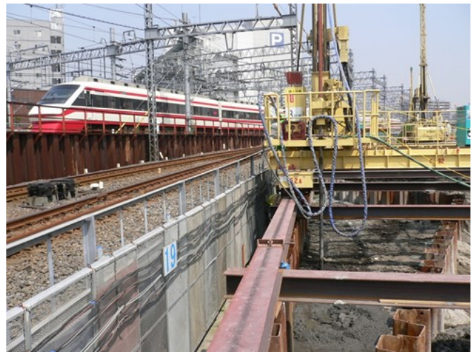
写真-1 施工状況 (営業線近接施工)
