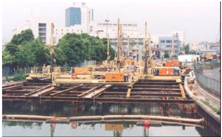
写真-1 施工状況
