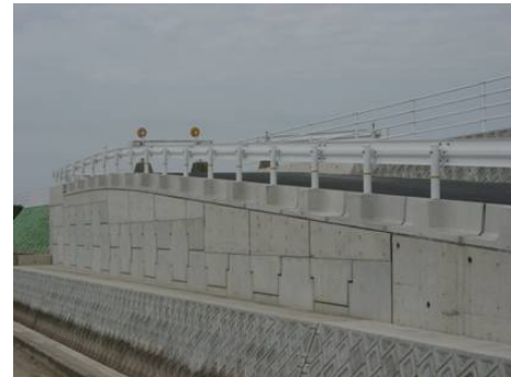
写真-5 補強土壁への設置
