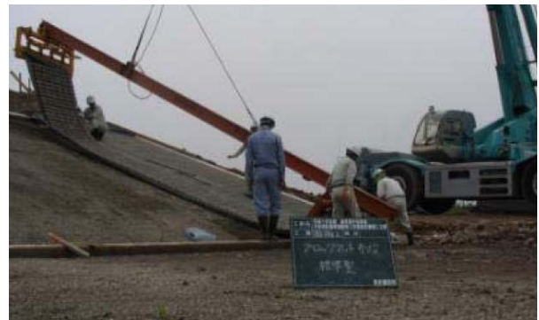
写真一 2 ソルコマット施工状況
