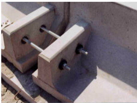
写真-2 連結部の状況 (コンクリート打設前)
