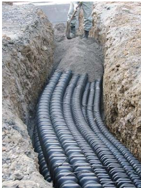
写真-3 一括埋め戻し状況
