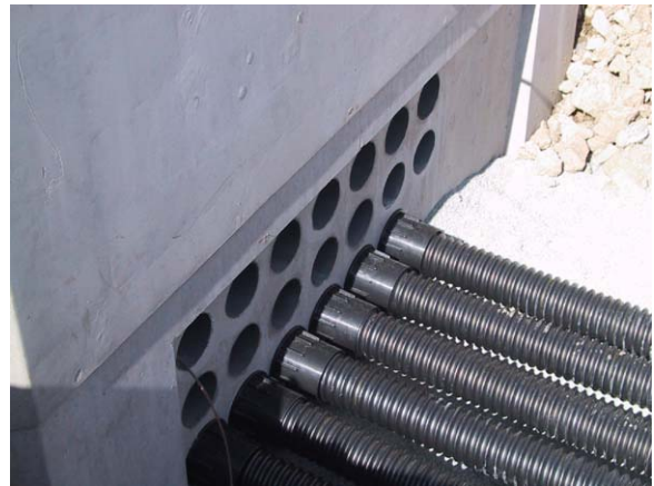
写真一 2 中部国際空港灯火施設設置工事
