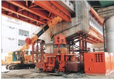
写真一 高速道路の橋脚補強
