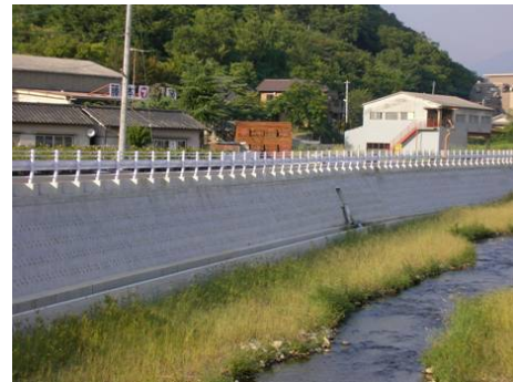
写真-3 間知ブロックへの設置
