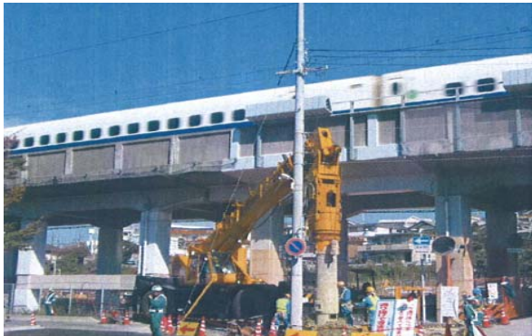
写真1 上空制限（新幹線欄干）下施工
