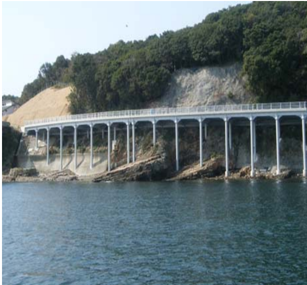
写真一 1 兵庫県洲本灘洲本灘賀集線 歩道新設工事
