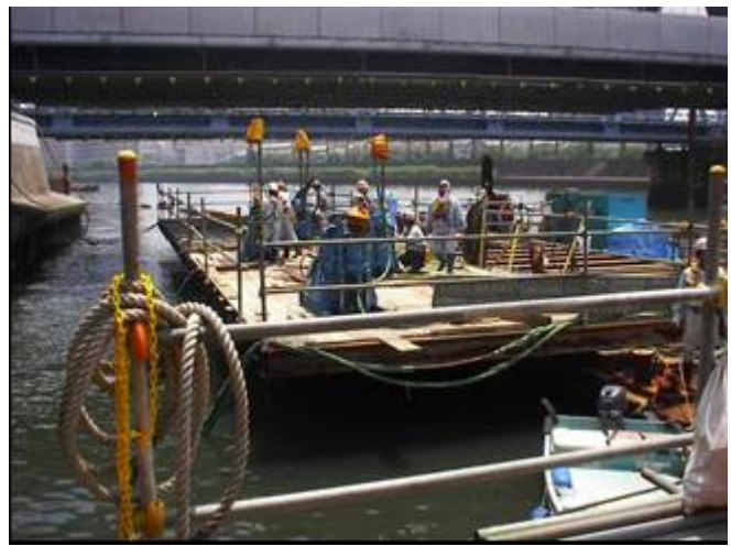
写真-1 施工状況 (水中施工事例)
