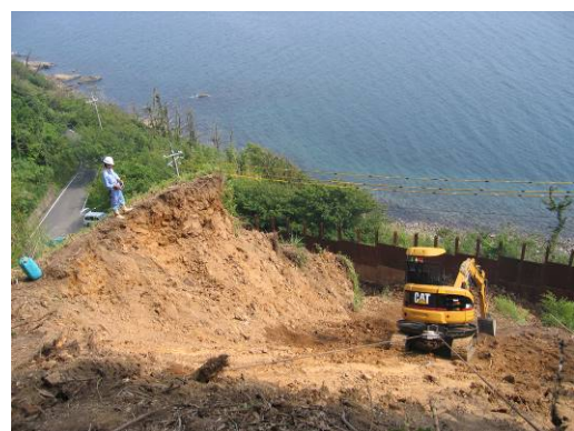
写真-2 遠隔操作
