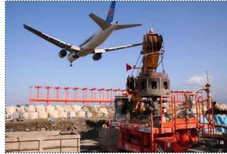
写真二 空港内作業制限下の施工
