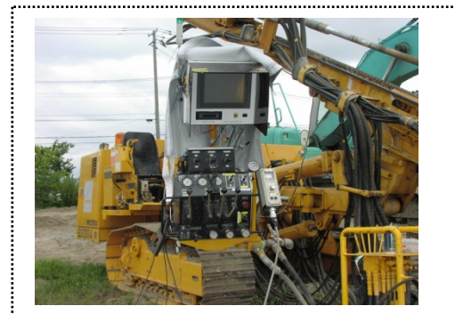
写真一 2 削孔管理装置
