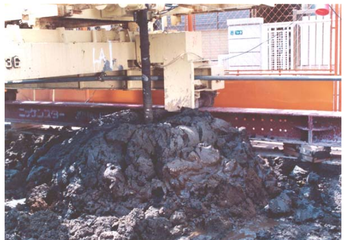
写真-2 LD i s 工法排土状況
