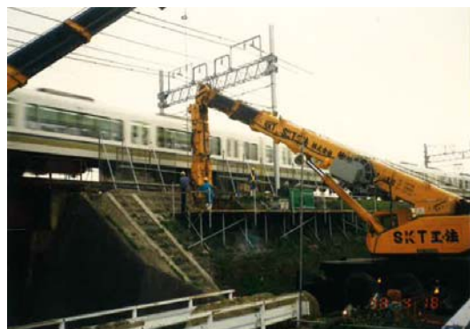
写真2 列車近接施工
