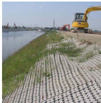
写真一 4 ソルコマット標準型 敷設後1ヶ月経過植生状況
