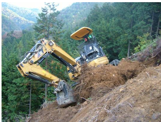
写真-1 作業状況
