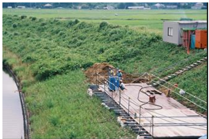
写真-2 施工状況 (陸上施工事例)
