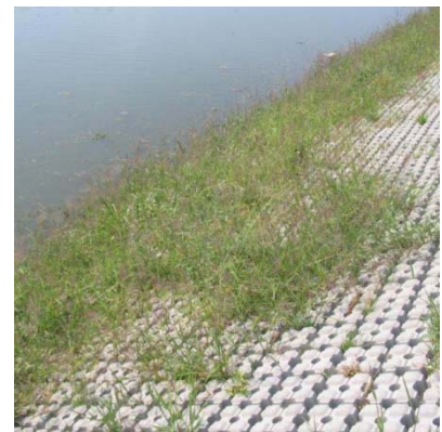
写真一 5 ソルコマット標準型 敷設後1ヶ月経過植生状況
