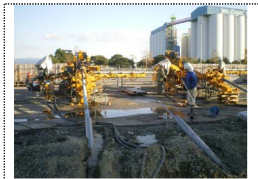
写真一 1 施工状況
