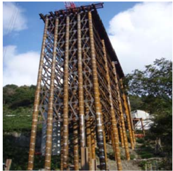
写真一 2 富山県庄川橋梁下部工事
