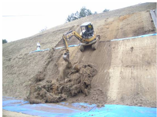
写真-4 除染工事での適用
