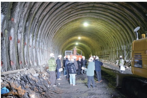
平成26年2月に貫通した坂祝トンネル（1号）
