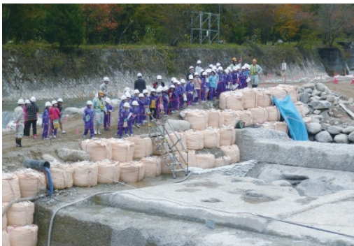
地元小学生が、摩耗や損傷した部分を取り除いた砂防施設を見学（川上流路工）
