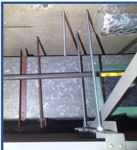
各部位ごとに吊り材を設置
