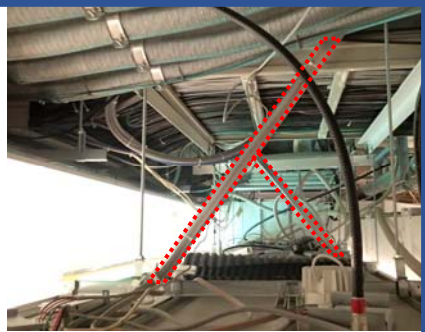
野縁、野縁受け、吊りボルトが緊結
