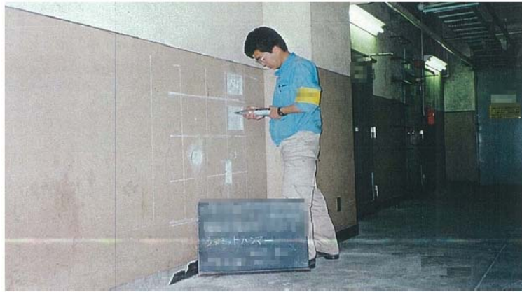
写真 3-2-6 リバウンドハンマーによるコンクリート強度推定状況
