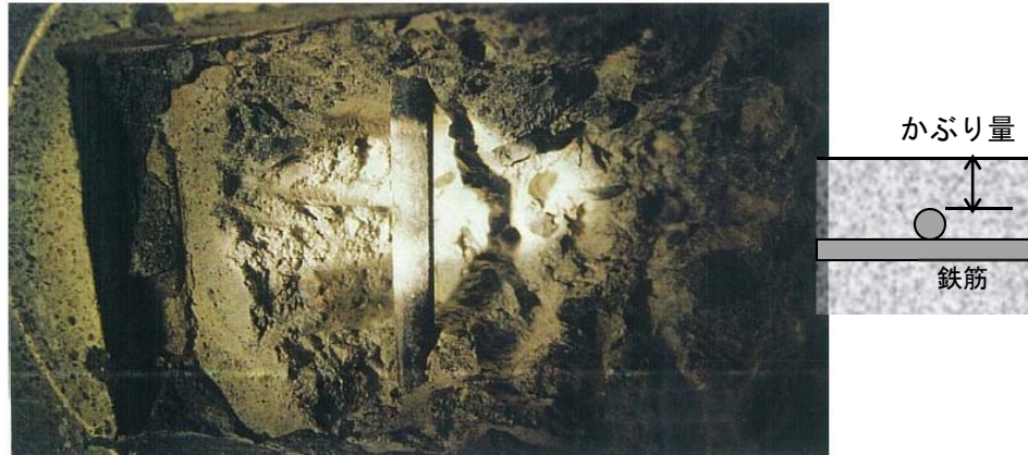
写真 3-2-8 鉄筋露出調査状況
