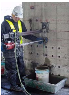
①コアボーリングによる削孔
