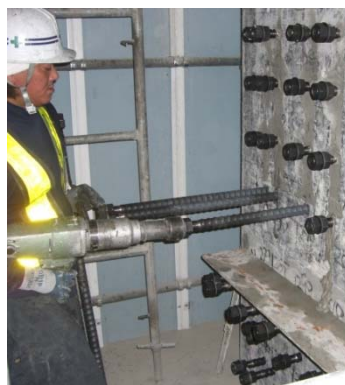
②補強鉄筋挿入
