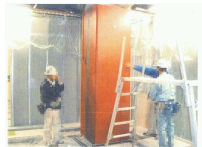
施工写真 (⑥鋼板建込み)
