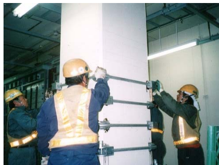
②コーナー支持材設置、鋼材締め付け
