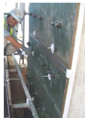
③補強鋼板取付 ④鋼板・既設柱間に樹脂を注入し施工完了
