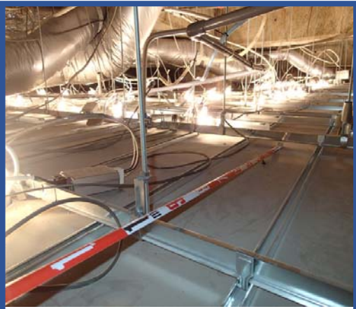
野縁、野縁受け、吊りボルトが緊結
