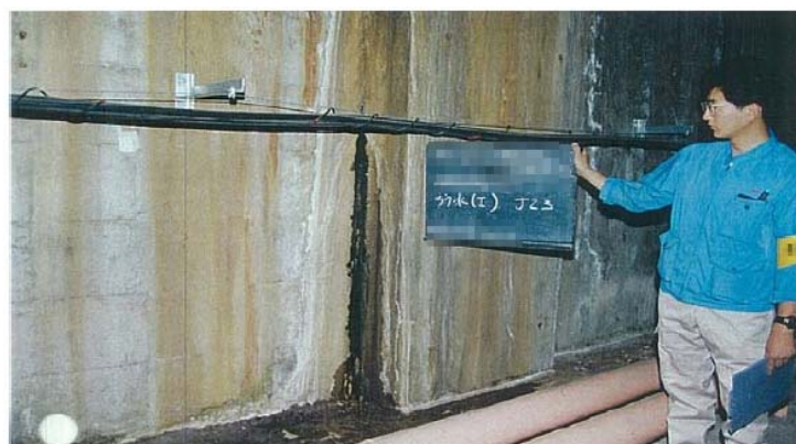
写真 3-2-3 漏水調査状況
