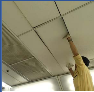
エアーカーテン機器を構造物からの吊り材で固定
