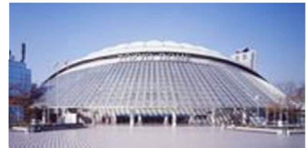
出典：株式会社東京ドームHPより
