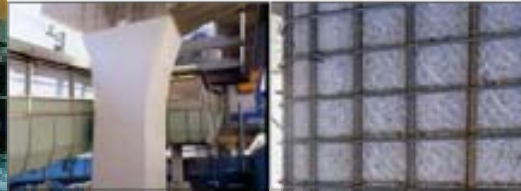
橋脚に鉄筋を追加
