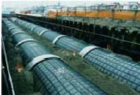
パイプライン側上部に特殊なネットを敷き、施設を強化
