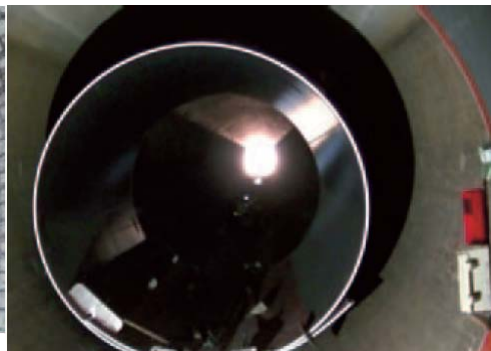
サイホン内に鋼管を挿入し補強
