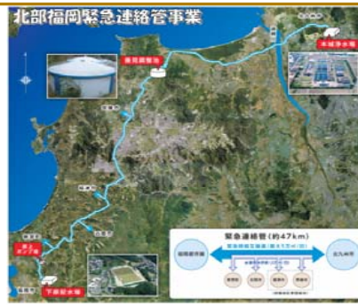
↑北部福岡緊急連絡管事業
