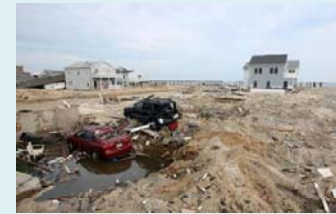
沿岸部の家屋損壊状況 ©USACE
