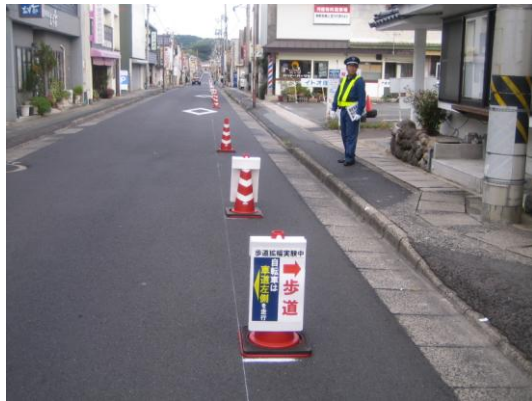
▲ 三角コーン等の設置状況（1車線部）
