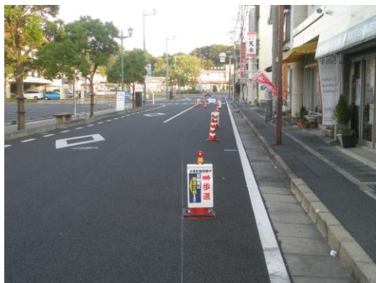
▲ 三角コーン等の設置状況（2車線部）
