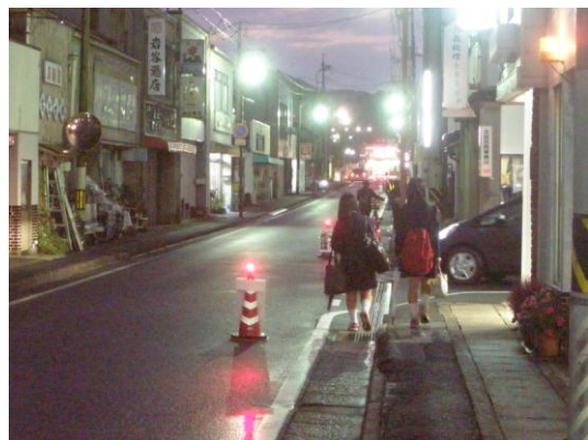
▲ 三角コーン等の夜間の状況（1車線部）
