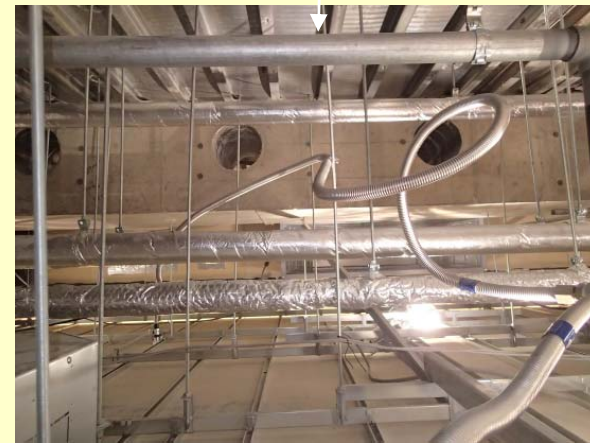
デッキスラブの施された天井内観でそれぞれの吊り材が整然と配置されている。
