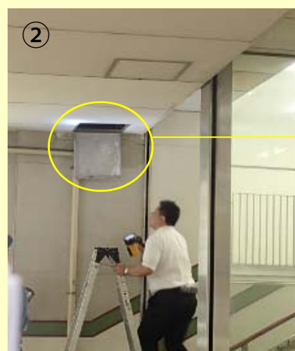
② 隣接部に点検口があるため、内観を点検。
