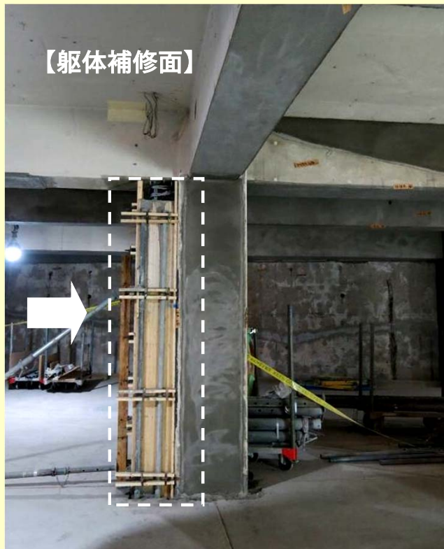
(柱補強コンクリート打設中)
