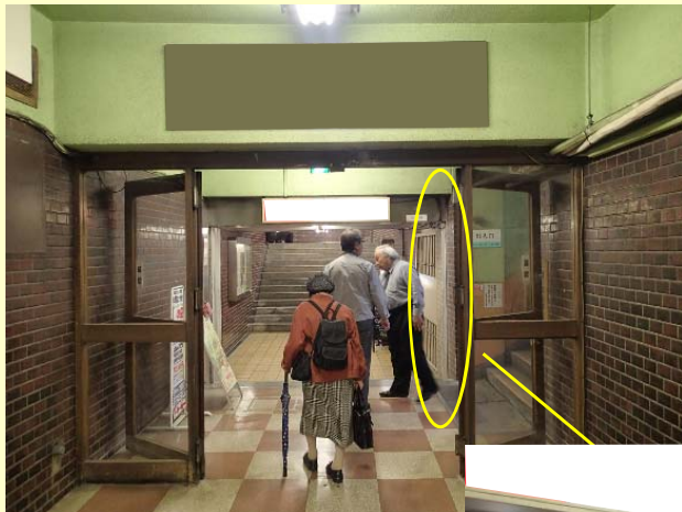
接続ビルとのEXP.J部に漏水跡が見られる。
