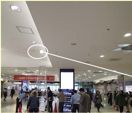
形状上がり、フラット 在来ボードCH=3.4~4 m
