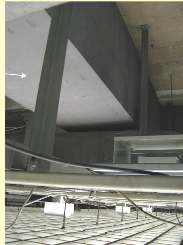
天井内 懐 1.8m 鋼材からブーバー天井が吊られている
