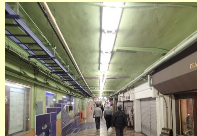
天井材のないスケルトン天井の事例。
