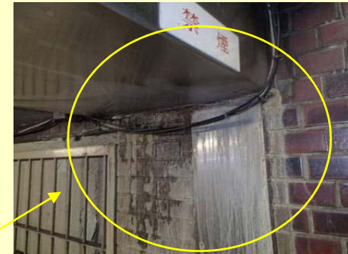
接続ビルとのEXP.J部に漏水跡が見られる。
