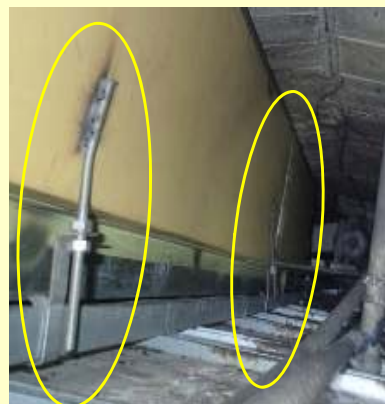
シャッター機器に溶接固定された吊りボルトにより、天井下地が吊られている。
