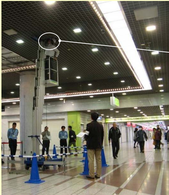
ルーバー CH=4.6m 高所作業車の設置による点検
