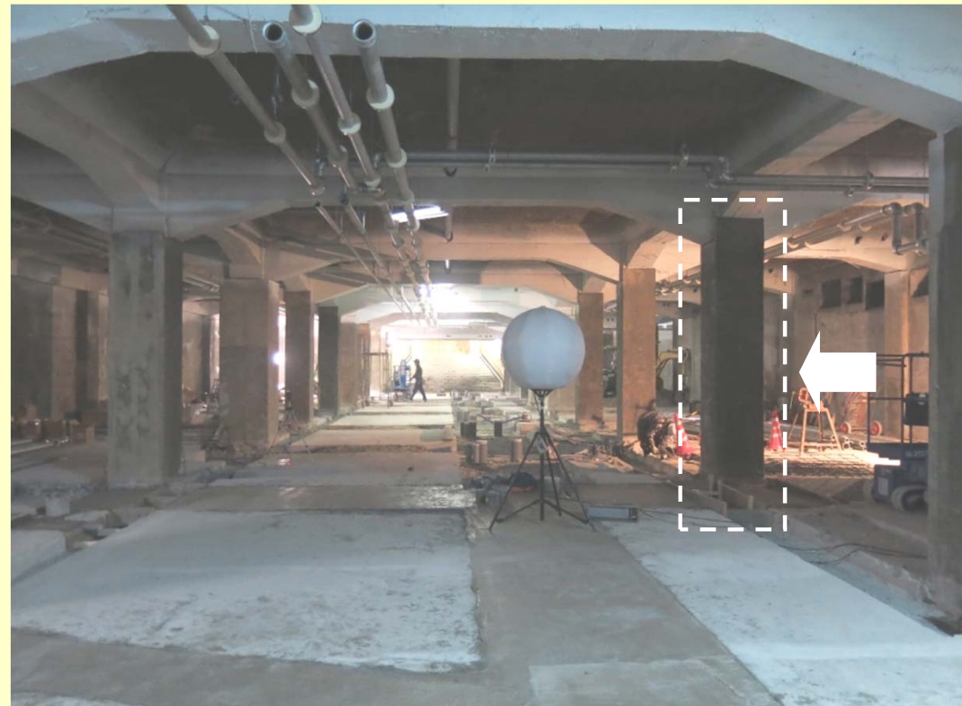
躯体補修、及び柱補強（炭素繊維巻）
