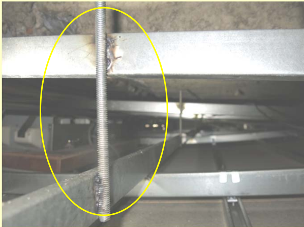
吊りボルトの下地材への溶接。
