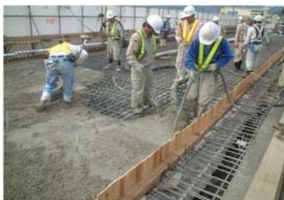
床版上面のコンクリート打設
