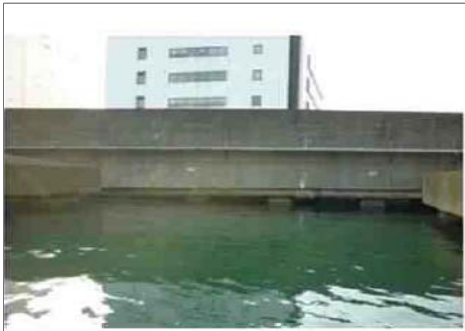
海水面に最も近接している箇所(大井埠頭橋付近)
