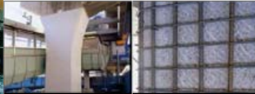
橋脚に鉄筋を追加
