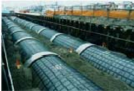
パイプライン側上部に特殊なネットを敷き、施設を強化
