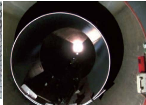
サイホン内に鋼管を挿入し補強
