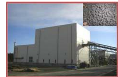
宮城県南浄化センター【造粒乾燥】 (平成21年度より稼働) (50t-wet/日)
