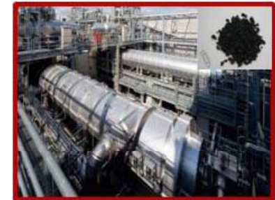
広島市西部水資源再生センター【炭化】 (平成24年度より稼働) (100t-wet/日)
