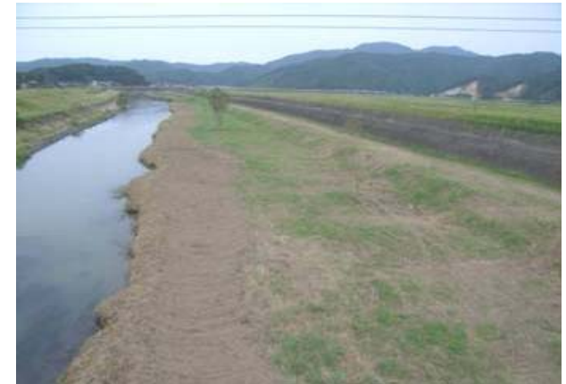
河道内の樹木の繁茂
