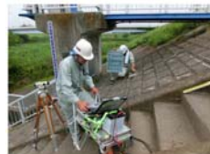
▲機器による点検の例 (護岸の背面空洞化調査)
