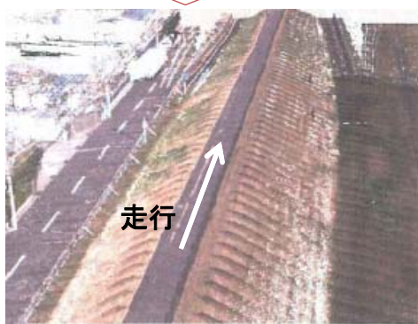
堤防等を実測したレーザ点群
