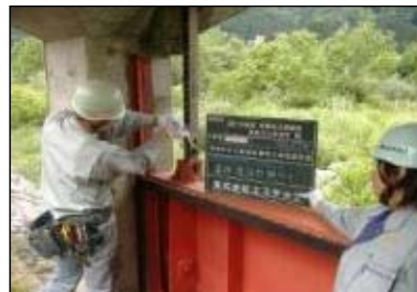
(樋門ゲートの点検)
