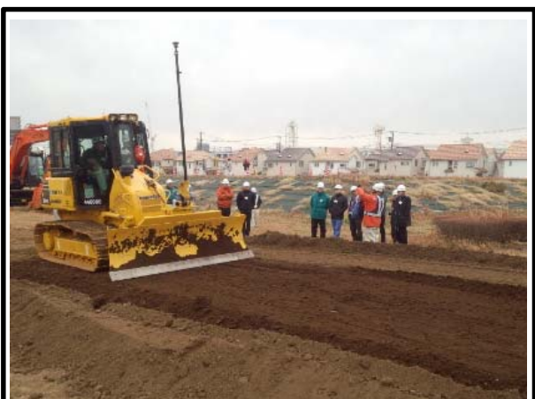
(一社)日本建設機械レンタル協会の協力によるMCブルドーザの実操作体験。
