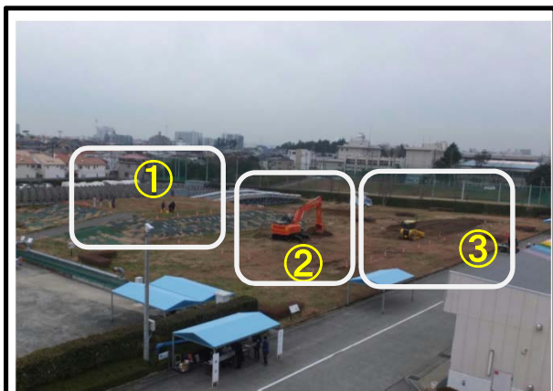
講習会場全景 ① TS出来形エリア ② MGバックホウ ③ MCブルドーザ
