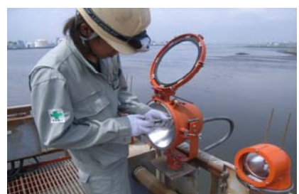
点検を踏まえた補修の実施
