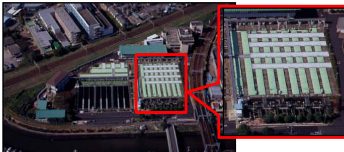
熱田水処理センター(愛知県名古屋市) 1930(昭和5)年整備(約82年経過)
