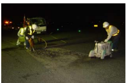
点検を踏まえた補修の実施
