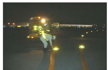
航空灯火施設の点検
