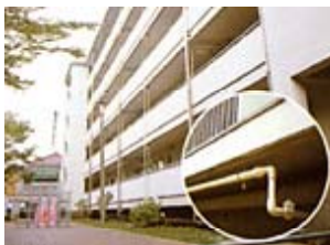
<配管のメンテナンス>
