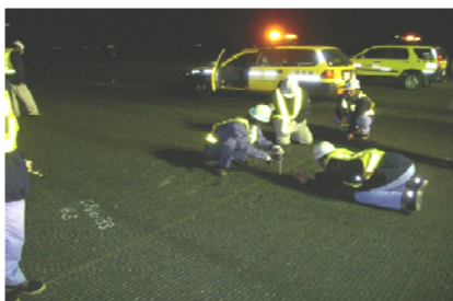
空港基本施設の点検
