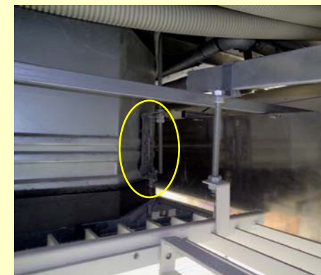
ユニット4隅吊りボルト取付
