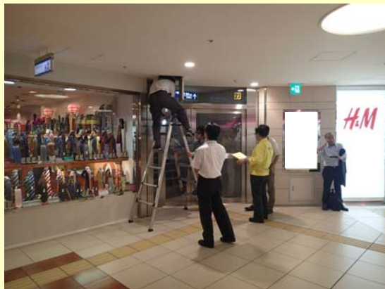
フラット・石膏ボード天井 C H3.0m
