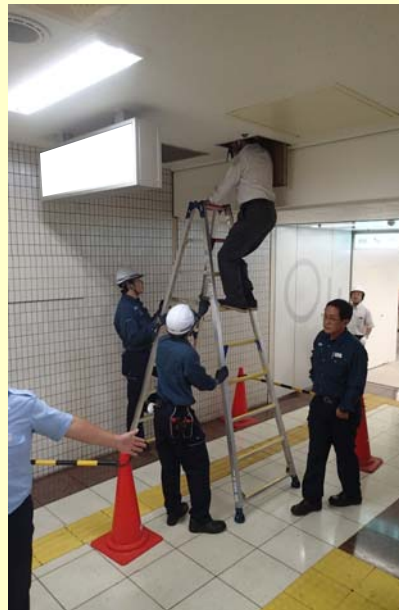
フラット・岩綿吸音板C H2.5m
