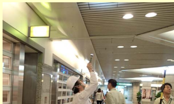
天井面に自動閉鎖の垂れ壁
