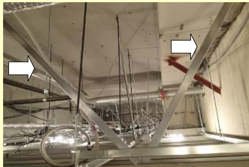
【振れ止めが設置されている事例】
