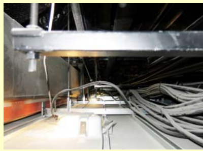
フラット・アルミルーバー天井 C H2.5m 懐1.1m
