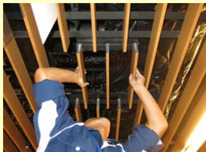
フラット・アルミルーバー天井 C H2.5m 懐1.1m
