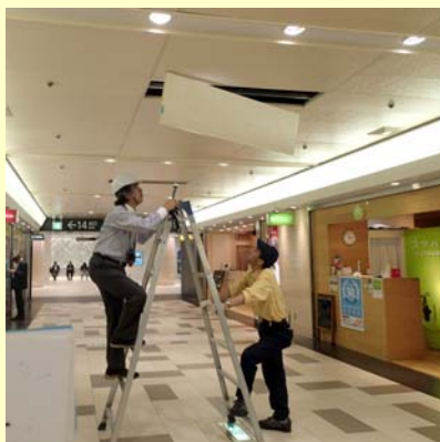
フラット・アルミパネル t 1.0mm 0.35×1.8m 落下防止SUSワイヤー付き
