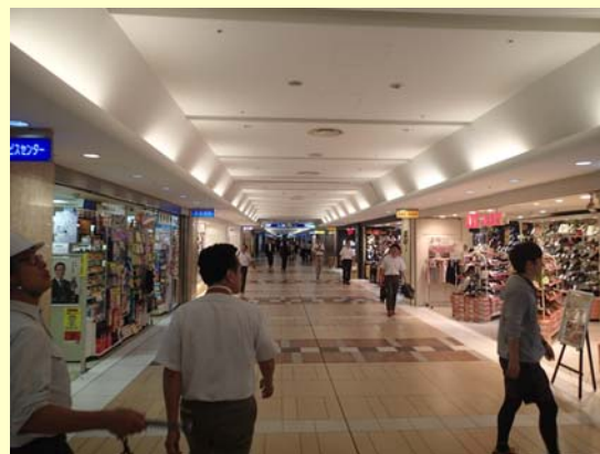
山型・石膏ボード天井 C H3.6m
