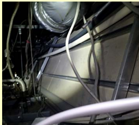
山型・石膏ボード天井 C H3.6m
