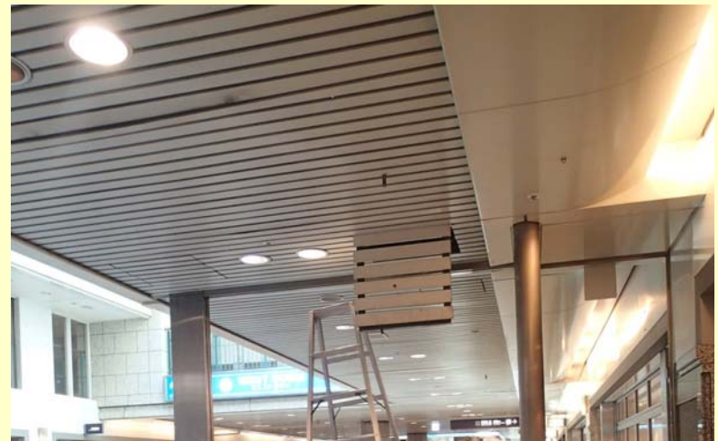
フラット・アルミルーバー天井 CH3.0m 天井懐3.5m
