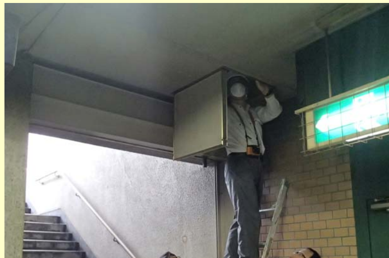
フラット・石膏ボード天井C H3.0m
