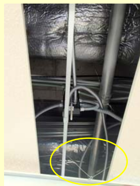
フラット・アルミパネル t 1.0mm 0.35×1.8m 落下防止SUSワイヤー付き
