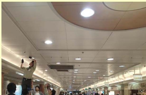
フラット・スチールパネル 0.6×1.2m天井C H3.0 天井懐0.25m
