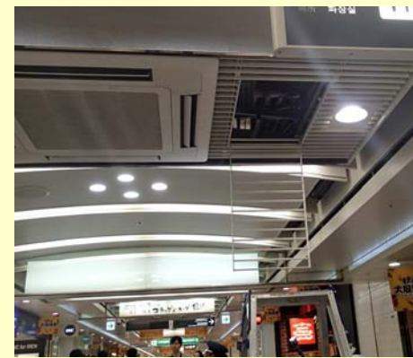
アルミパネル天井 ファンコイルユニットガラリ点検口
