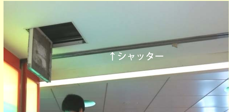
シャッター廻り フラット・石膏ボード天井 CH3.0m
