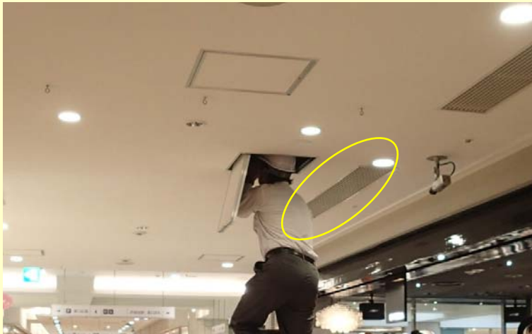
フラット・石膏ボード天井 CH3.0m
