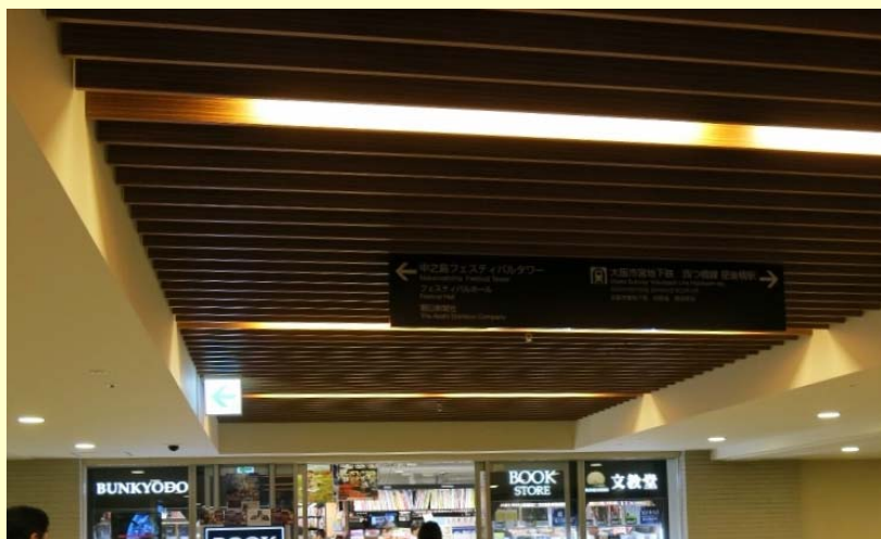
フラット・アルミルーバー天井 C H2.5m 懐1.1m
