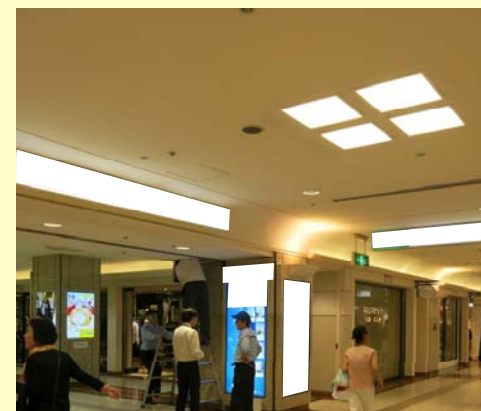
フラット・石膏ボード天井 C H3.0m 懐1.1m
