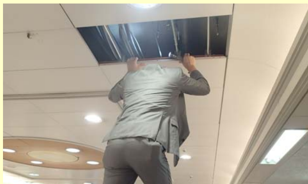
フラット・スチールパネル 0.6×1.2m天井C H3.0 天井懐0.25m
