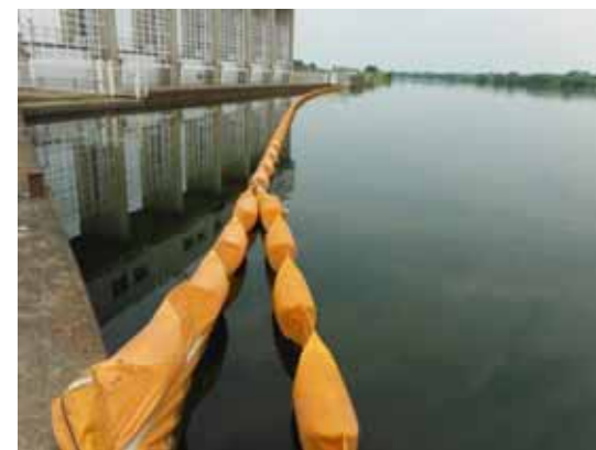
オイルフェンス設置(秋ヶ瀬取水口)
