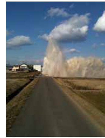
老朽化による送水管破裂事故
