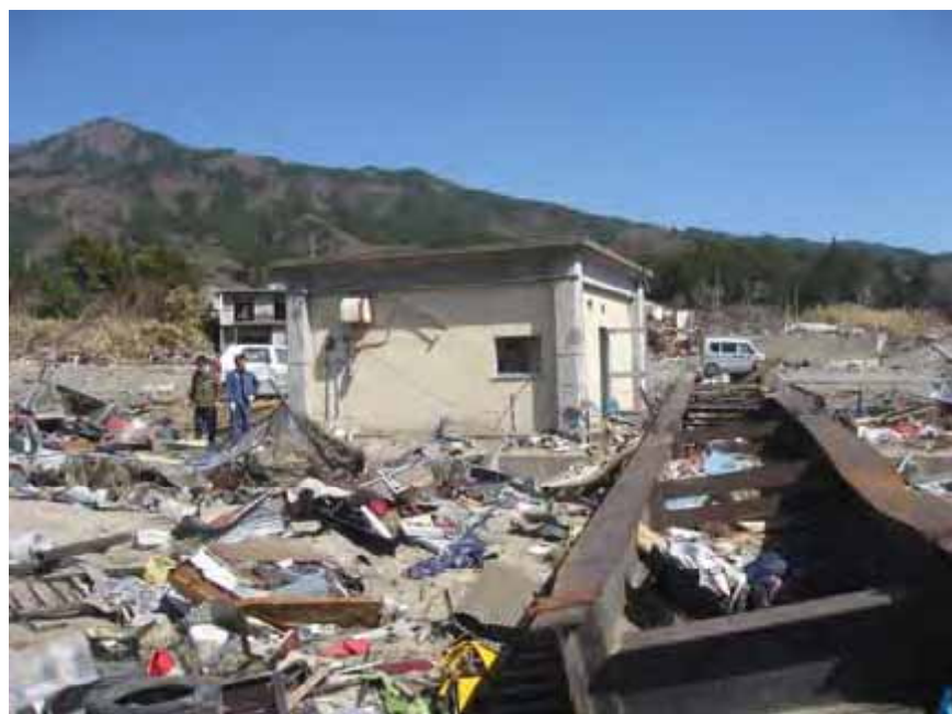
津波による加圧ポンプ所の被災例(岩手県大槌町浪坂ポンプ場)
