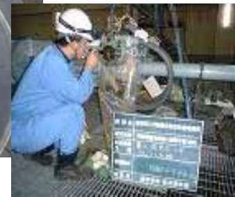
設備の分解整備
