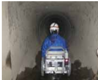
管内走行状況
