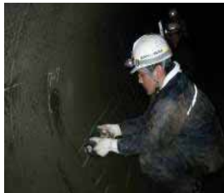
電磁誘導法の測定状況
