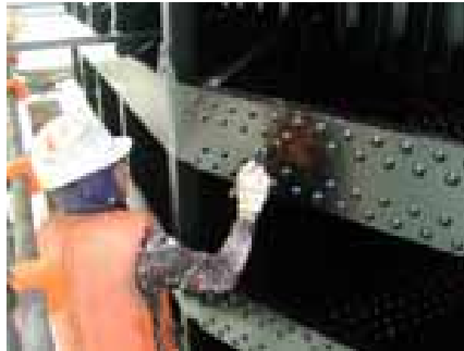
ダムゲートの塗装
