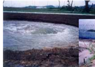
伊良湖サイホン漏水状況
