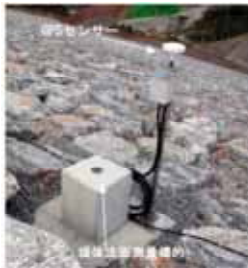
外部可動標的基礎に 設置したGPSセンサー
