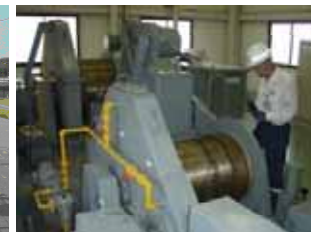
ゲート設備等の点検
