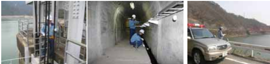
ゲート設備等の点検
