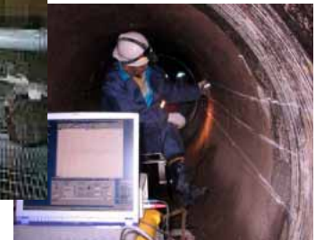
水路内面から調査
