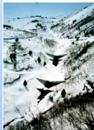
雪崩の発生危険箇所をもつ砂防えん堤（長野県白馬村）
