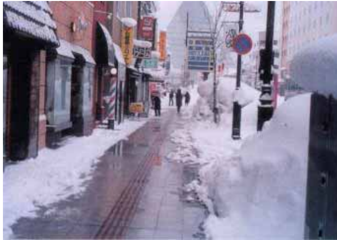
【ロードヒーティングによる歩道融雪】
