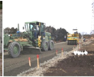
丁張りに合わせて施工
