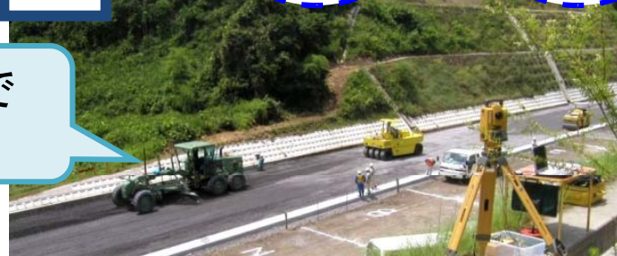
建設機械が設計データを読み込み施工
