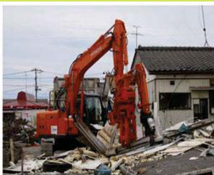
津波で押し流され市街地の路地を塞いでいたコンテナを、その場で解体・分別して移送。(石巻市)
