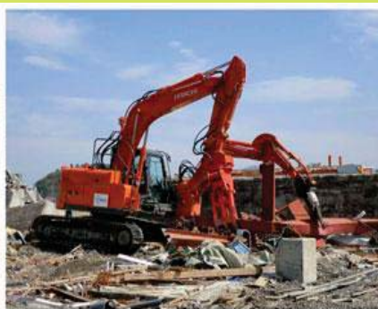
複雑に絡み合う建屋構造物、基礎材などの鉄スクラップを細かく切断、分別して移送。(南三陸町)
