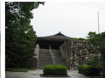
【宮島町水質管理センター】
