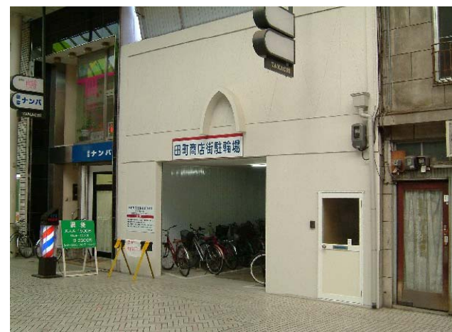
商店街内に設置された駐輪場
