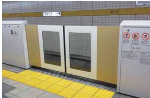
図表2-6-8 ホームドアの設置状況
