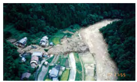
■豊田市 (旧稲武町) において発生した土石流 (H12)
