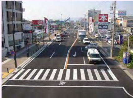
▼写真：3車線化された国道248号
