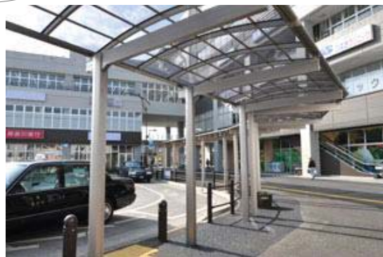
連続して設置されたバスシェルター (高座渋谷駅西口)
