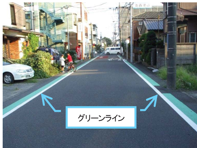
道路幅が狭く、歩道設置が難しい道路に整備されたグリーンライン
