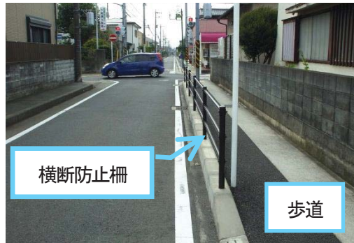
改修された歩道と新設された横断防止柵
