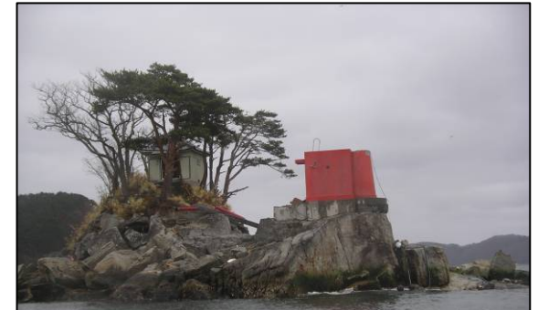
津波により倒壊した大槌港灯台(釜石海上保安部所管)
