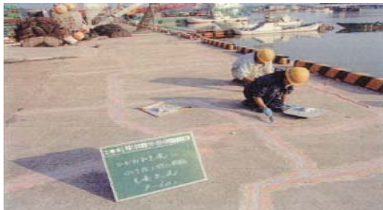
▲ エプロンのひび割れに樹脂を充填
