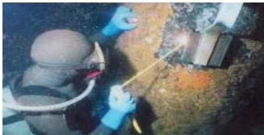
▲ 水中溶接による電気防食の施工
