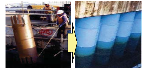
▲ 鋼管杭を鋼板で補強
