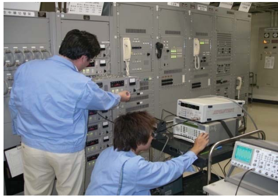
航空保安無線施設の点検
