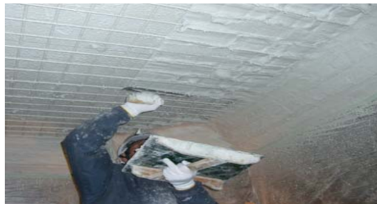
▲ 増厚工法による補強
