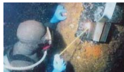
⑤電気防食(水中溶接技術)
