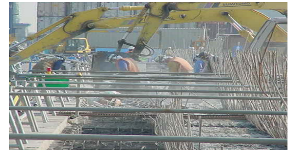
▲ 床版の打ち替え
