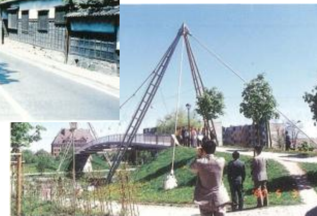
意匠・創造性に配慮した事例 (ドイツ、ミュンヘンの歩道橋)
