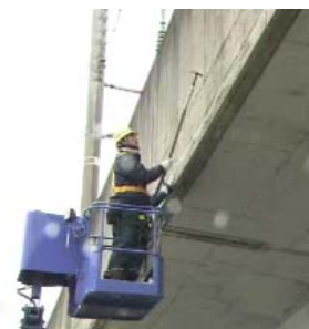
【高架橋点検の様子】
