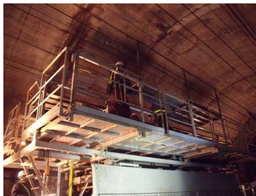
【トンネル天井部の点検の様子】
